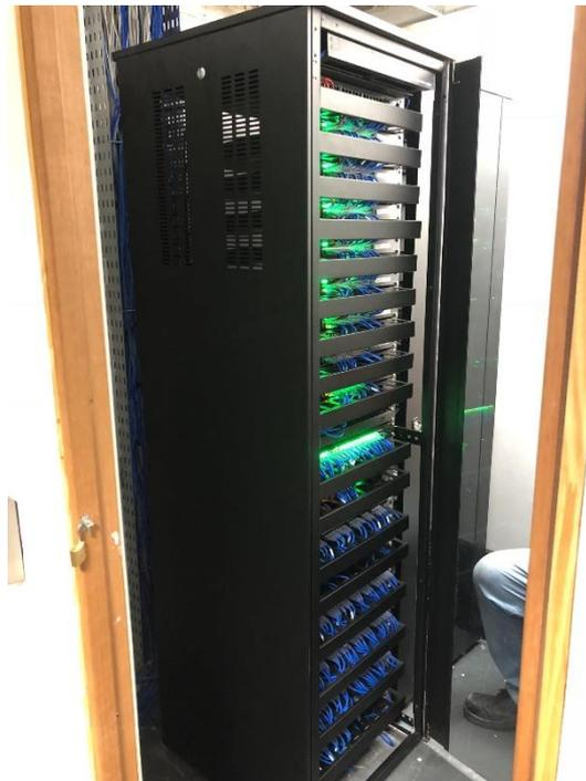
Cabeamento estruturado em 4.450 pontos de Rede Cat5 e VOIP. Maio/2018.
